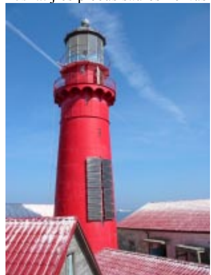
Bākas darbam nepieciešamo elektroenerģiju nodrošina tornim piestiprinātās saules baterijas
